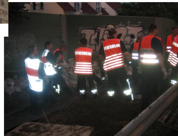
In Ketten werden Sandsäcke zum Bau eines Rückhaltebeckens weiter gereicht
